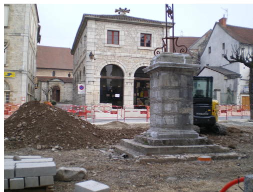
Une vue des travaux
